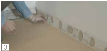
3 Posizionare i distanziali lungo il perimetro Fit the spacers around the outer edge
