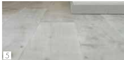
5 La superficie risulterà perfettamente planare The finished floor will be perfectly flat
